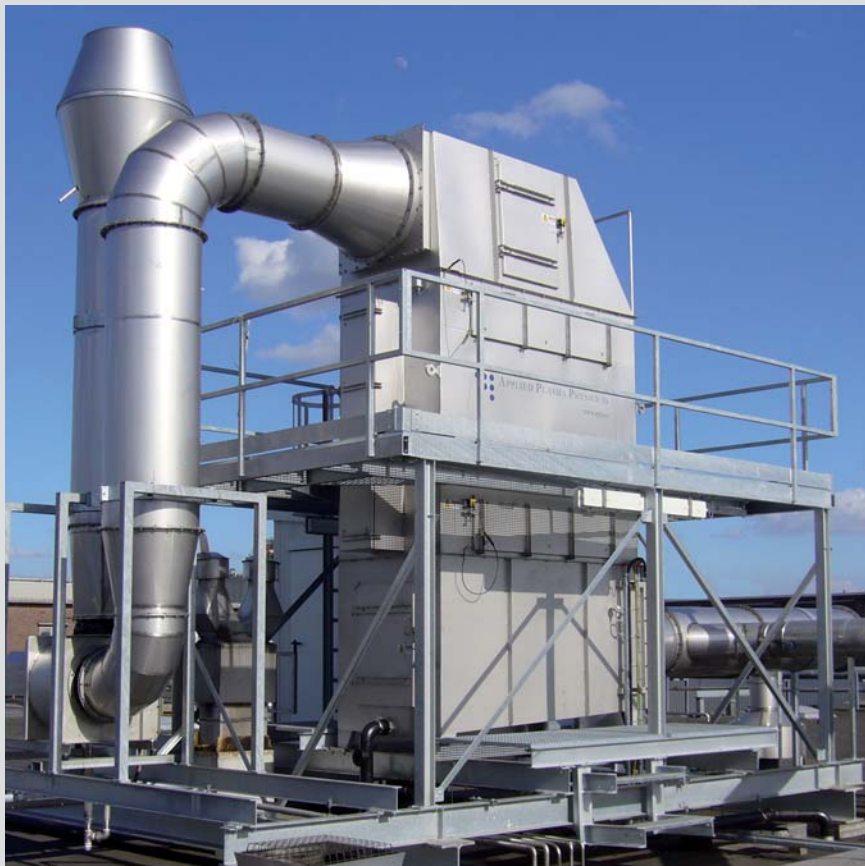
Geurcomponenten worden afgebroken en stofemissies gereduceerd met de 'non-thermal plasma' APP-technologie
